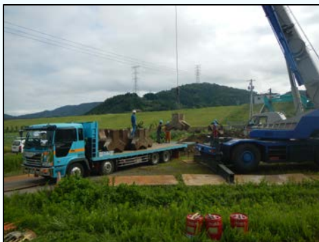
根固めブロック運搬状況
