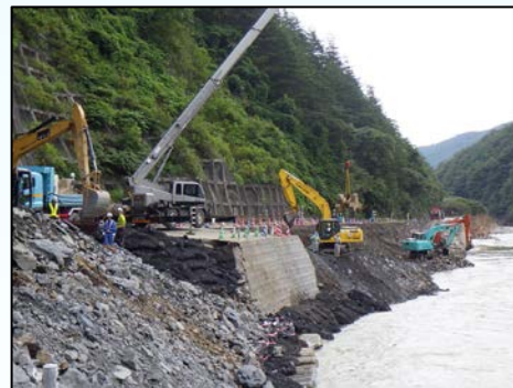
根固めブロック設置状況
