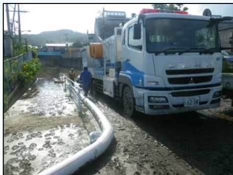
排水ポンプ車作業状況
