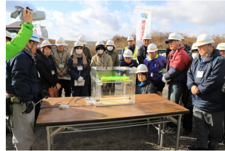
模型を使った大林水門ゲート設備の説明
