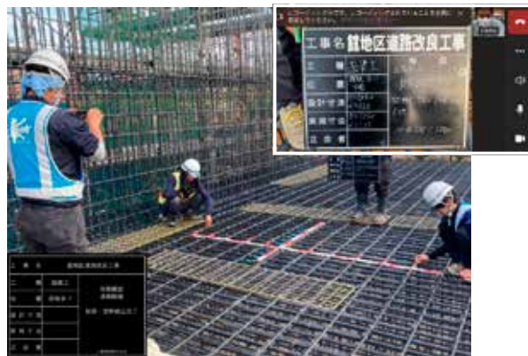
遠隔臨場による鉄筋出来形測定
