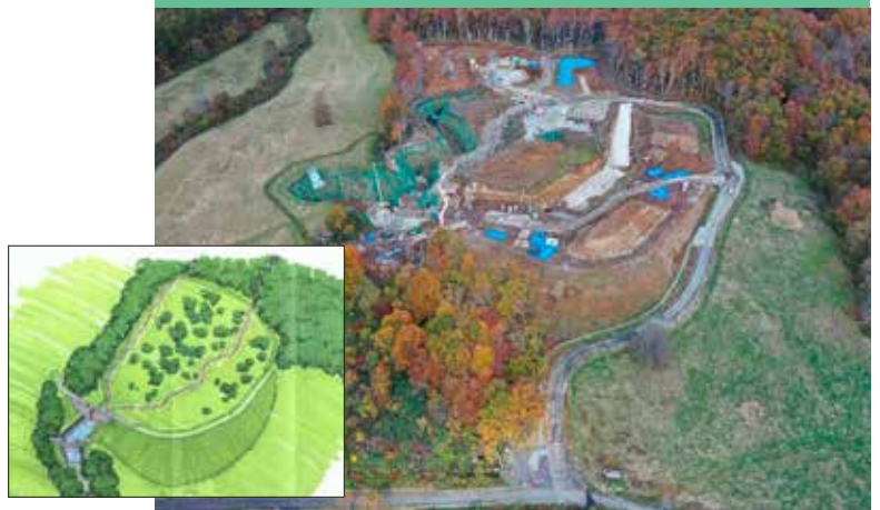
③うさぎ平西沢砂防堰堤 R5実施内容：砂防堰堤工
