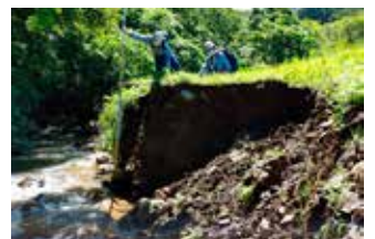
TEC-FORCE活動状況 (令和4年8月豪雨 青森県深浦町)
