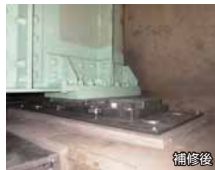
橋梁補修(主桁補修工、支承取替工)
