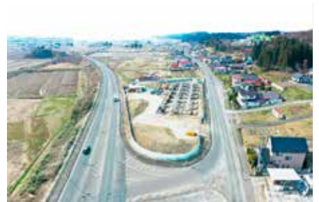
防災除雪ステーション(整備中)
