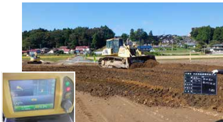
ICT建設機械による盛土施工
