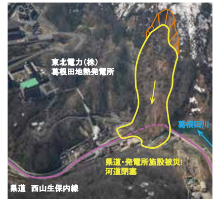
葛根田川で発生した大規模崩壊
