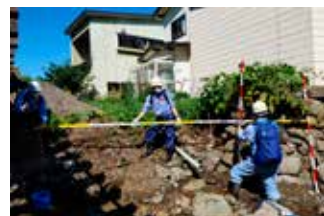
TEC-FORCE活動状況 (令和4年8月豪雨 青森県深浦町)
