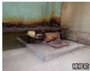
橋梁補修(主桁補修工、支承取替工)
