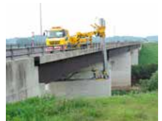
橋梁定期点検
