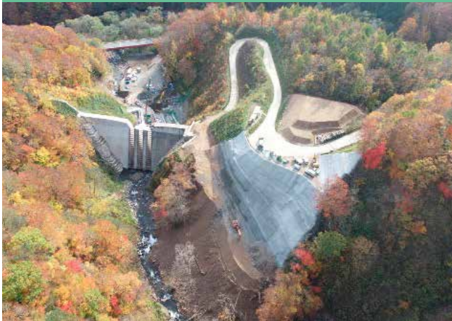
①シガラ沢砂防堰堤 R5実施内容：砂防堰堤工(管理用道路)
