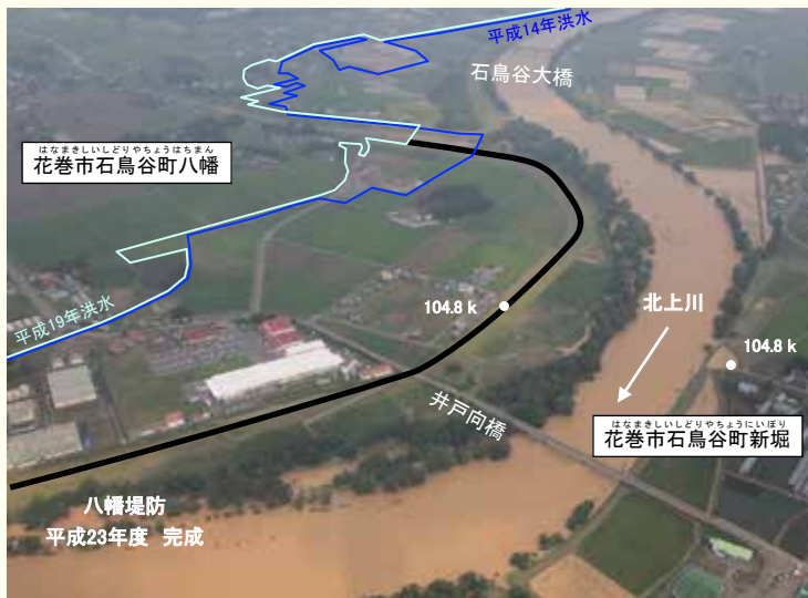
整備後(平成25年8月洪水)
