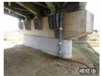
橋梁耐震補強 (横変位拘束構造)
