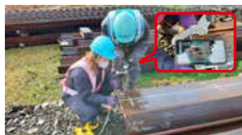
スマートフォンを使用した現場での検測状況
