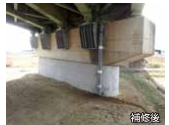
橋梁耐震補強 (横変位拘束構造)
