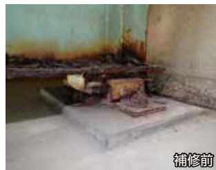
橋梁補修(主桁補修工、支承取替工)
