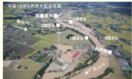
整備前(平成19年9月洪水)
