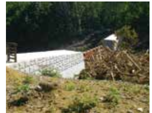
土石流発生後 (H25年9月17日)
