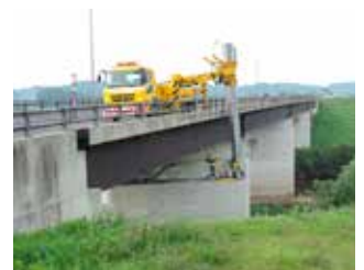
橋梁定期点検
