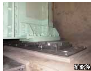
橋梁補修(主桁補修工、支承取替工)
