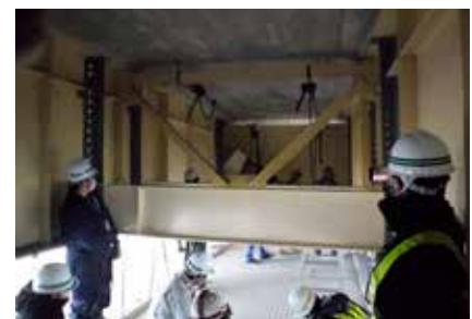
自治体向け講習会 (現場)
