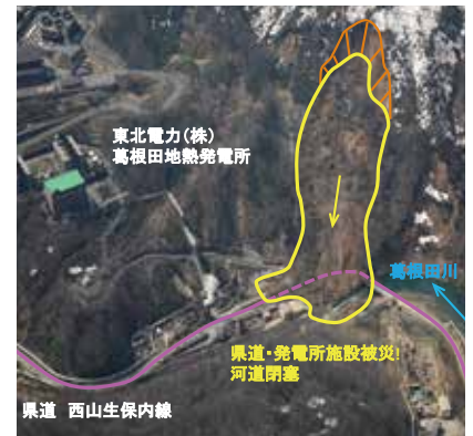
葛根田川で発生した大規模崩壊
