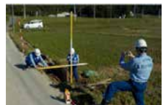
TEC-FORCE活動状況 (令和元年台風19号相馬市)
