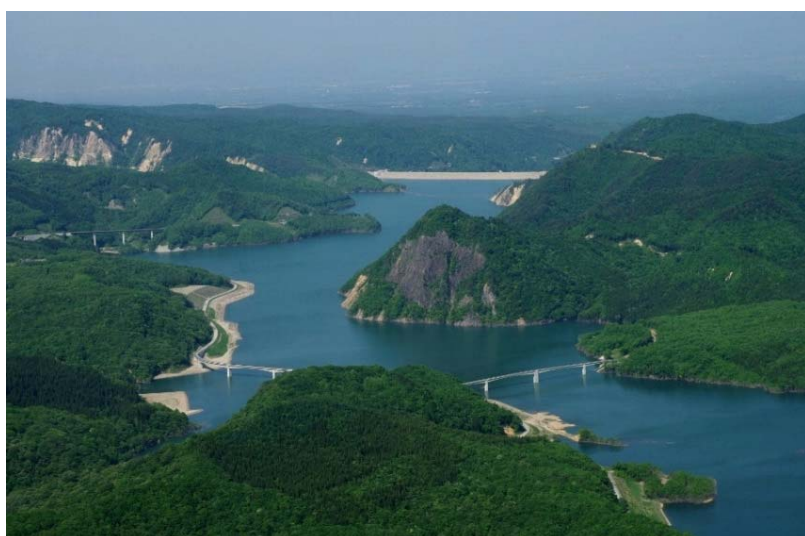
胆沢ダム貯水池(奥州湖) 平成25年6月
