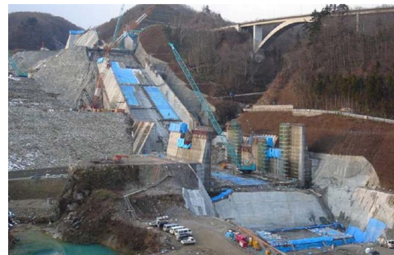
洪水吐コンクリート打設 (平成20年11月)
