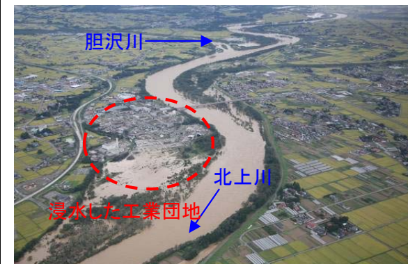
平成19年9月洪水による被災状況 (胆沢川合流点より下流)
