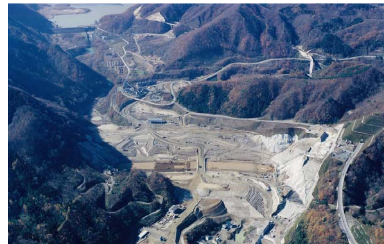
堤体盛立 (平成18年11月)
