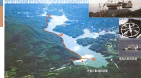
曝気循環施設の設置状況
