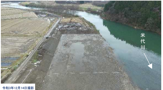
長坂地区河道掘削は、5万6千m3の土砂掘削を実施
