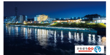
石巻地区かわまちづくり(宮城県石巻市)
