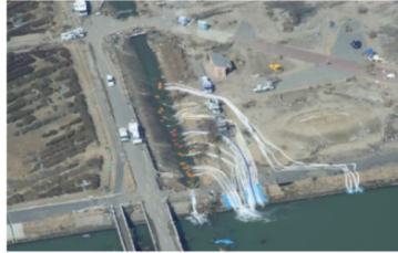
仙台空港再生に向けた排水作業 (宮城県名取市・岩沼市)
