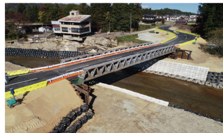
流出橋梁の応急復旧 【県道10号（大巻橋）山形県飯豊町】
