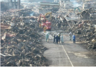
車が通れるルートを切り啓く道路啓開 (国道45号宮城県気仙沼市唐桑町)
