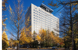
仙台合同庁舎B棟
