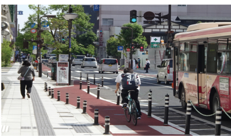
歩行者と自転車の錯綜回避のため 自転車道を整備した例 【国道112号 山形県山形市】
