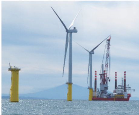
洋上風力発電設備の設置状況（秋田港）
