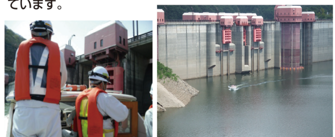
湖面よりダム堤体の点検状況
