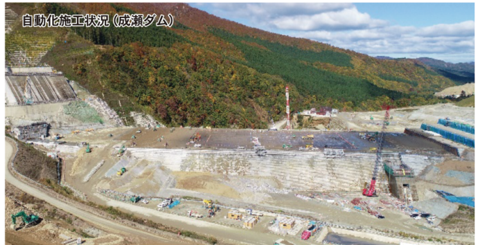
ICTを活用した施工の実施
