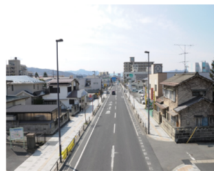
電線共同溝の整備状況
