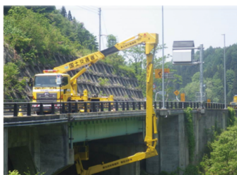
橋梁点検車による点検
