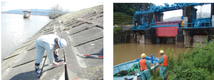
河川管理施設の点検状況
