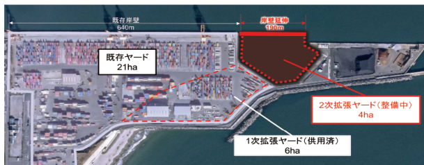
岸壁延長及びヤード面積の不足を解消する港湾整備を推進(仙台塩釜港 仙台港区)
