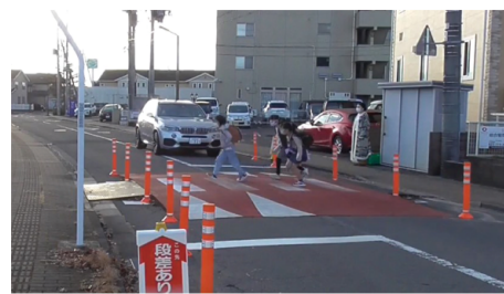
技術的支援として国土交通省が貸与した可搬型ハンプにより、スムーズ横断歩道（段差のある横断歩道）を設置した例 【宮城県富谷市】
