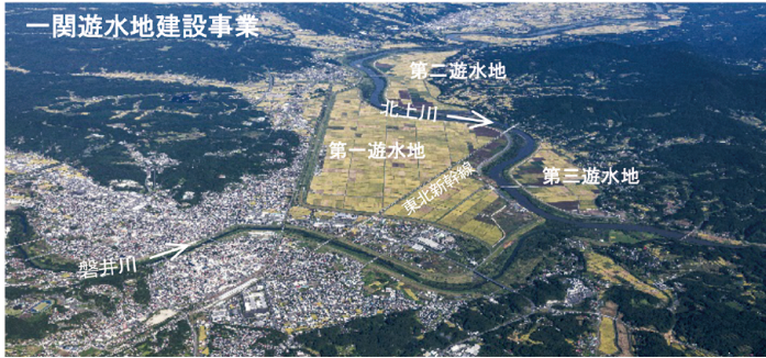
「流域治水対策」等の推進（遊水地整備）
