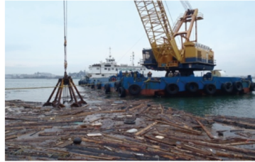
緊急支援物資受入れに向けた航路啓開 (仙台塩釜港石巻港区)
