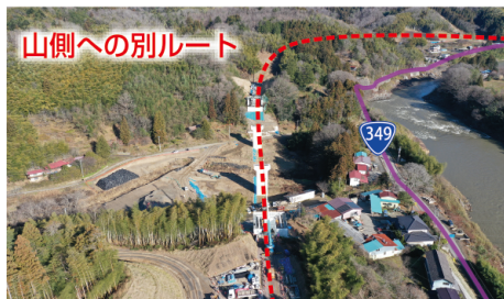
災害防止のための別ルート整備 【国道349号 宮城県丸森町】
