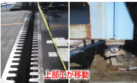
地震により被災した橋梁の復旧 【国道399号（伊達橋）福島県伊達市】
