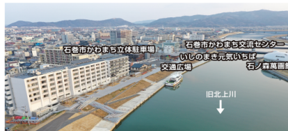
令和4年3月 旧北上川河口部の堤防整備が完了(宮城県石巻市)
