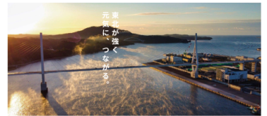
復興道路・復興支援道路 全線開通 全長570kmの道路網
