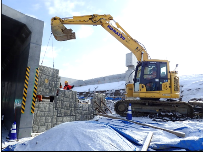
補強土壁工
