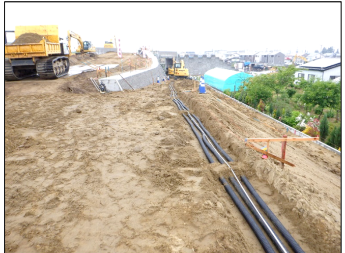
光ケーブル配管工
