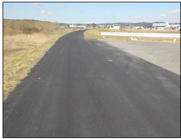
堤防天端舗装(浅水川付近)【打換え】後
