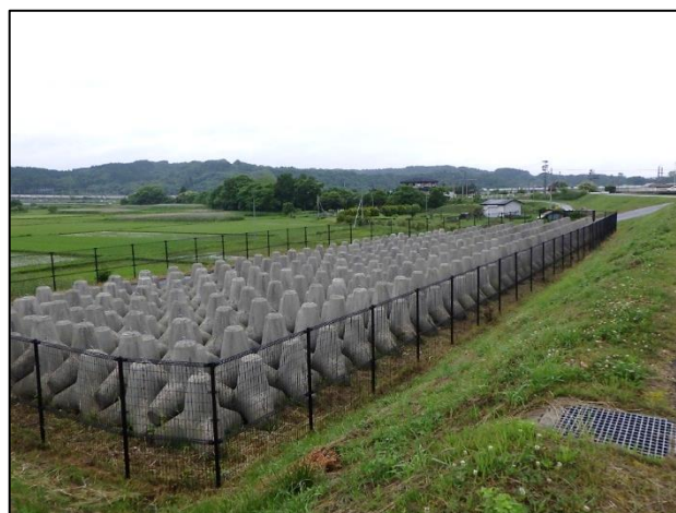
馬淵川防災ステーション資材置き場【除草】後
