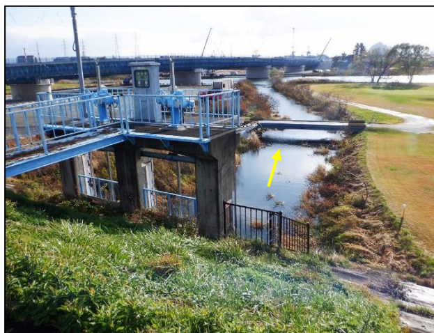
古川排水樋管堤外水路【樹木伐採】前
