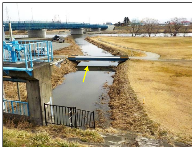
古川排水樋管堤外水路【樹木伐採】後
