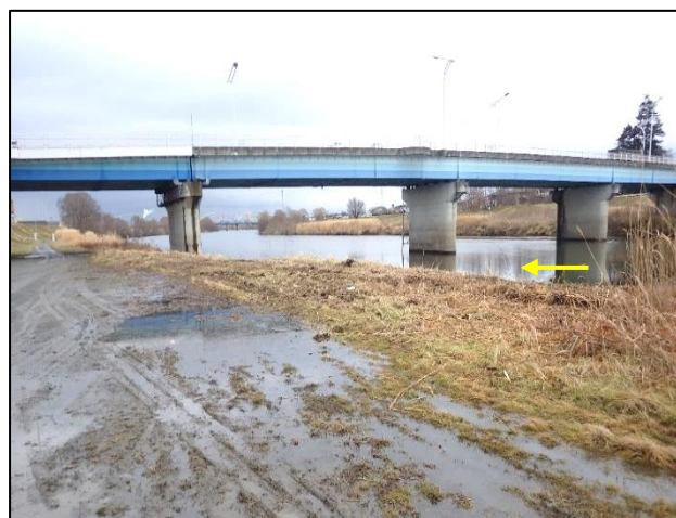
大橋上流(左岸)【樹木伐採】後
