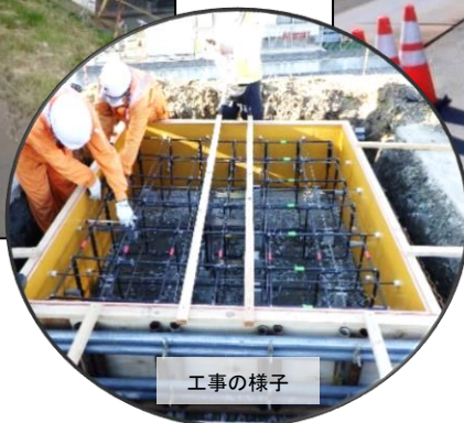
空中線柱基礎【工事】前
