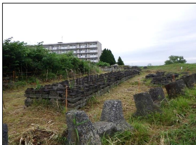
一日市資材置き場【除草】後
