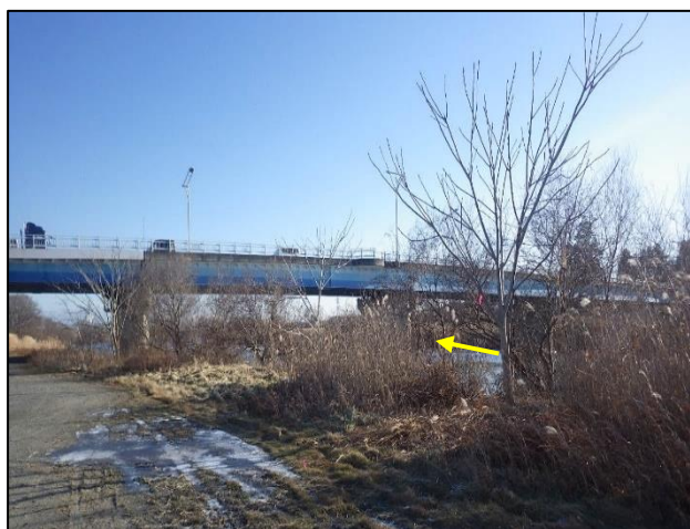
大橋上流(左岸)【樹木伐採】前
