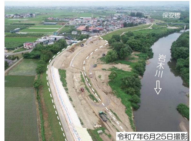
大型連節ブロック設置状況
