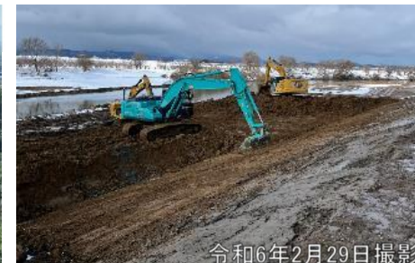
河道掘削状況
