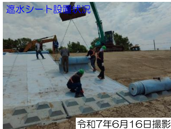
大型連節ブロック設置状況
