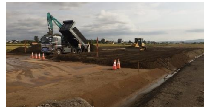
▲河道掘削土砂の搬入及び道路盛土施工状況
