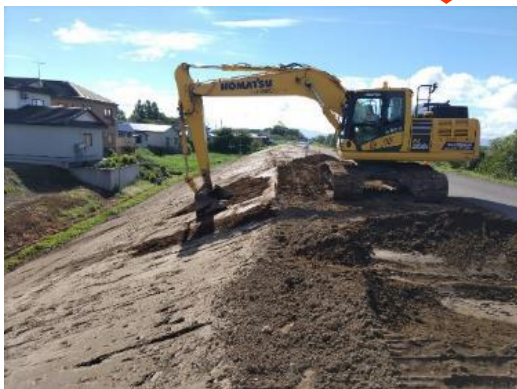
▲堤防強化（盛土）施工状況
