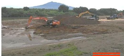
▲河道掘削の状況
