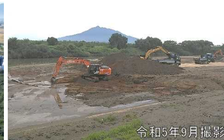
河道掘削状況
