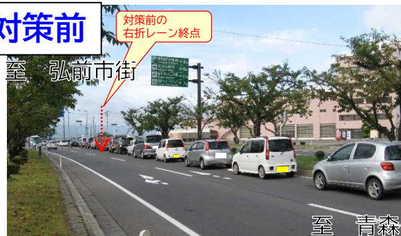
写真②滞留長不足により右折車が直進車を阻害
