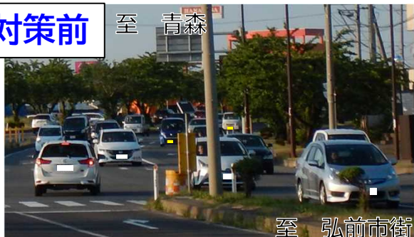
写真①カーブ区間で対向直進車の視認性が悪い
