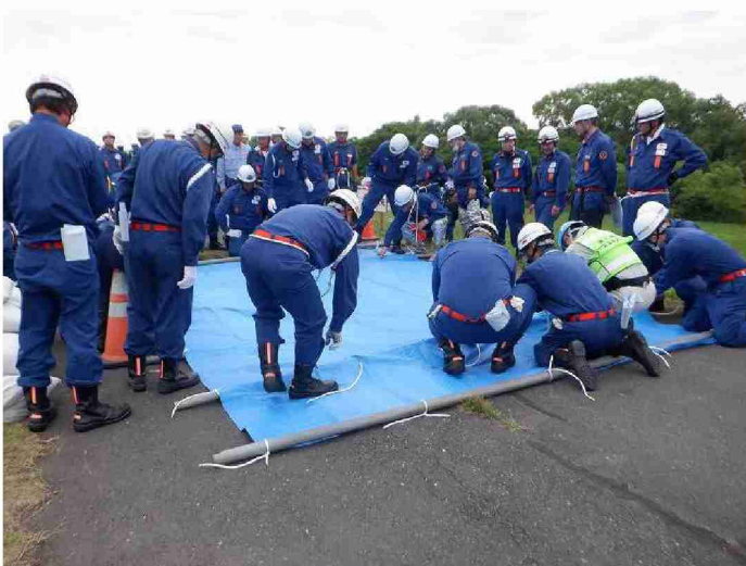
シート張り工の実施
