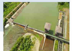
岩木川統合頭首工で撮影した写真 →
