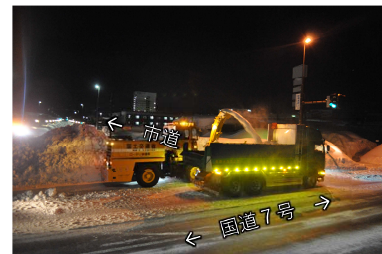
③ロータリー除雪車でダンプトラックに積み込み
