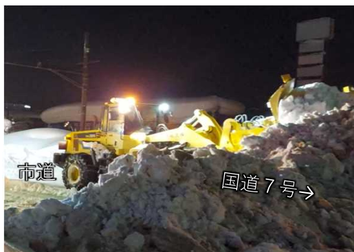
②国道7号に掃き出し
