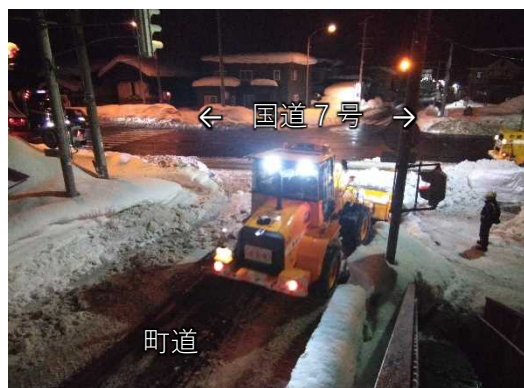
②国道7号に掃き出し
