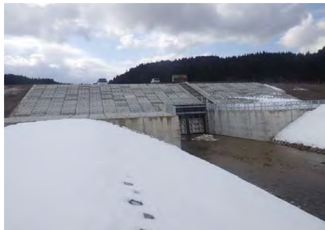
【雄物川下流繫地区築堤工事】
