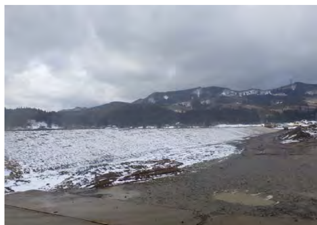
【雄物川下流新波下流地区築堤・掘削工事】
