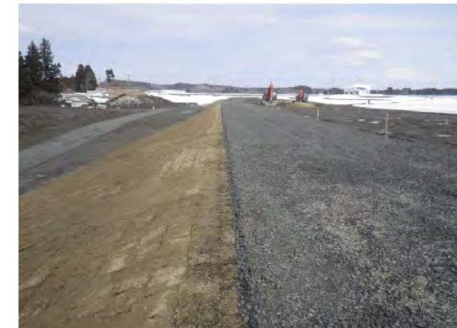
【雄物川下流清水木地区築堤・掘削工事】
