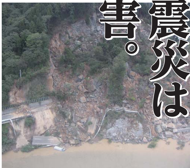
新潟県長岡市の土砂崩落で寸断された道路 (出典：北陸地方整備局)
