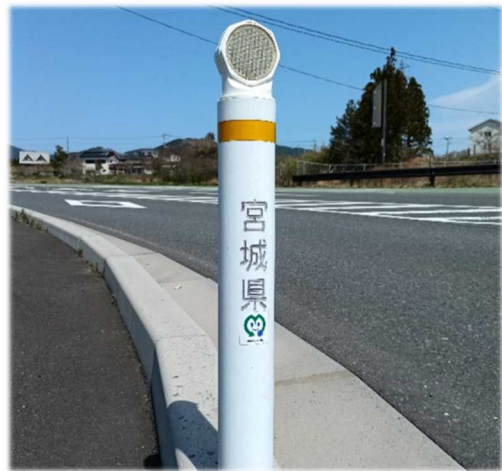
国道346号の視線誘導標
