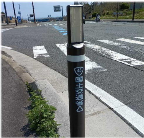
国道45号の視線誘導標
