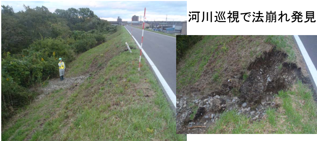
写真 2 - 3 兼用堤区間の法崩れ
