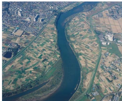
写真 5-1 H16 撮影斜め写真 (3.0k 付近)
