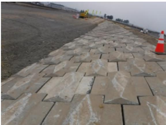
現場発生品のコンクリートブロックを堤防断面と側帯との縁切りとして再利用
