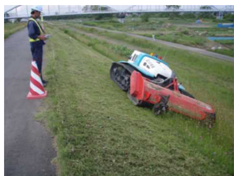
大型除草機械による除草
