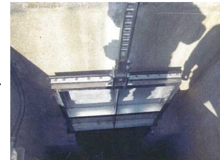
補修後(扉体ステンレス化)
