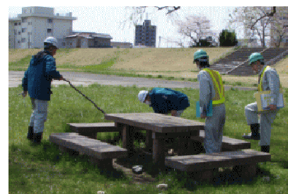
施設管理者と合同による点検 (広瀬川八本松緑地)
