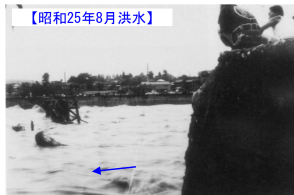
評定河原橋の流出
