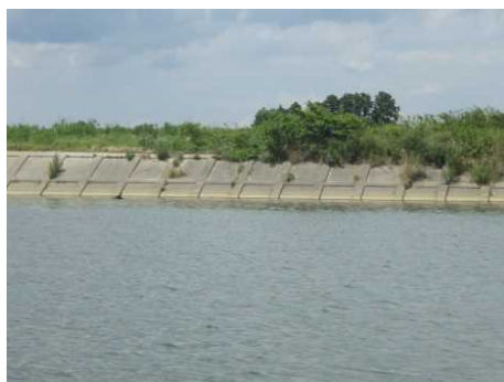
船上巡視による護岸点検
