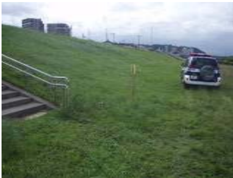
車上からの河川巡視
