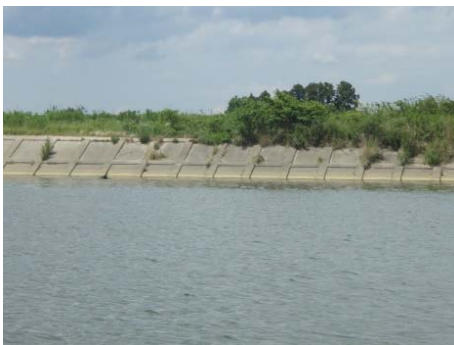
船上巡視による護岸点検
