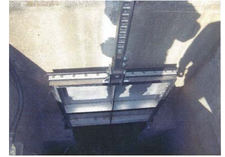
補修後(扉体ステンレス化)
