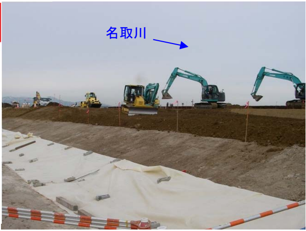
堤防盛土施工状況(地点①付近)
