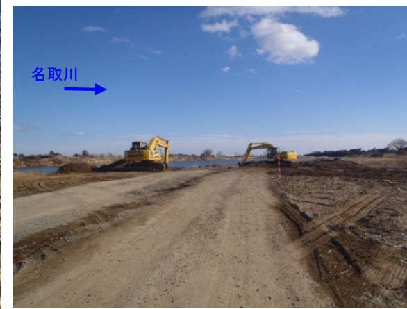
工事実施状況(右岸5.5km付近)
