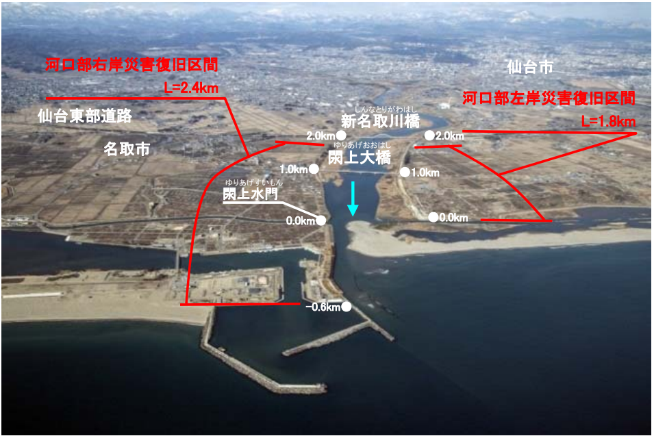
復旧状況斜め写真(平成26年1月7撮影)
