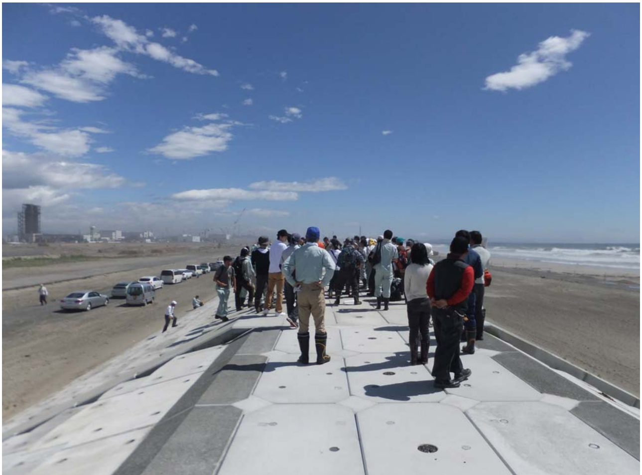
実施会場へ移動 作業前ミーティング
