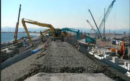
施工状況/山元海岸（坂元川）
