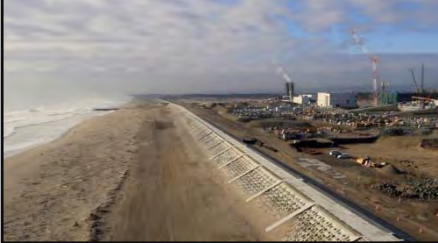
施工状況/仙台湾海岸（井土浦）
