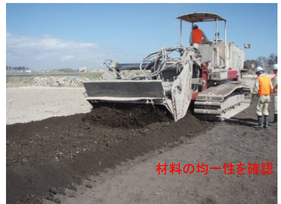
攪拌機による混合状況
