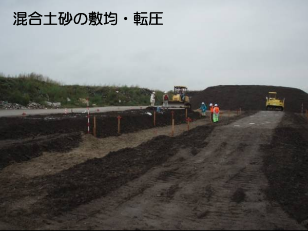
●津波堆積土砂、震災コンクリート殻、購入土を混合した土砂の活用実証試験状況
