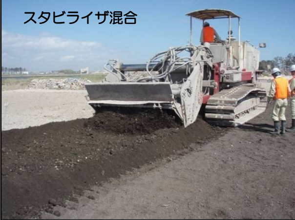
●津波堆積土砂、震災コンクリート殻、購入土を混合した土砂の活用実証試験状況
