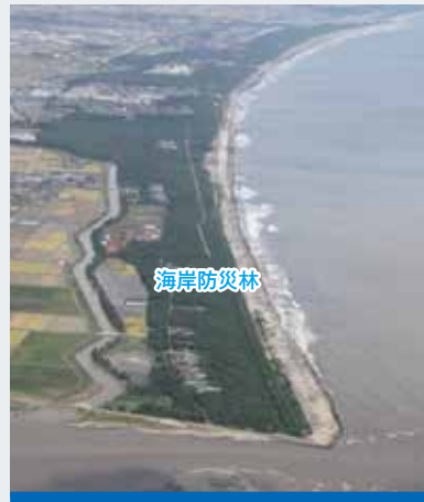
震災前 (H22.9.29) 阿武隈川河口付近から、名取海岸方面まで防災保安林が続いており、美しい海岸線を見る事ができました。
