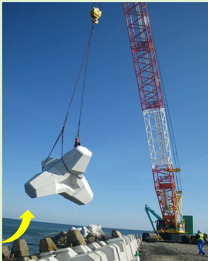
▲ブロック据付の様子
