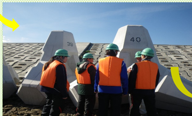
▲型を取ってブロックが完成した状態
