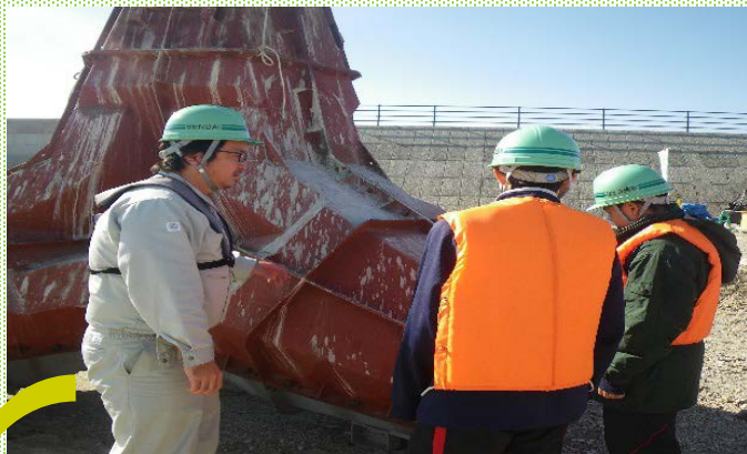
▲型にコンクリートを流しこみ固めている状態
