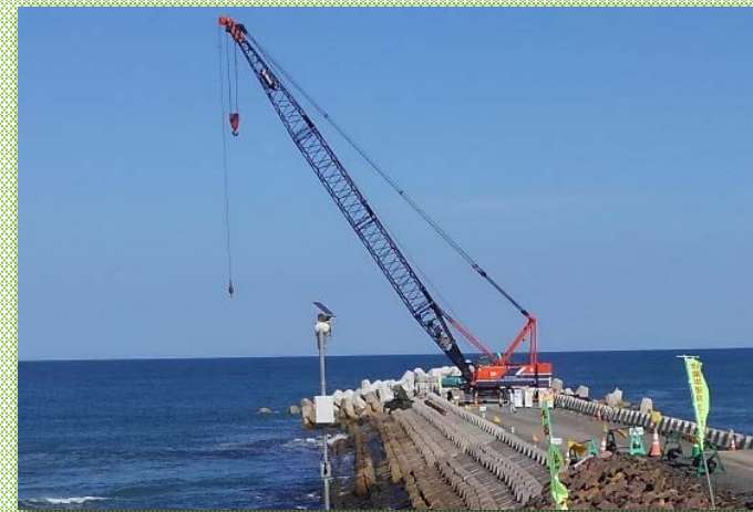
▲工事の状況 (H29.9.13)
