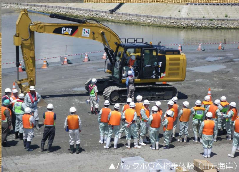
▲堤防上から工事現場の見学（山元海岸）
