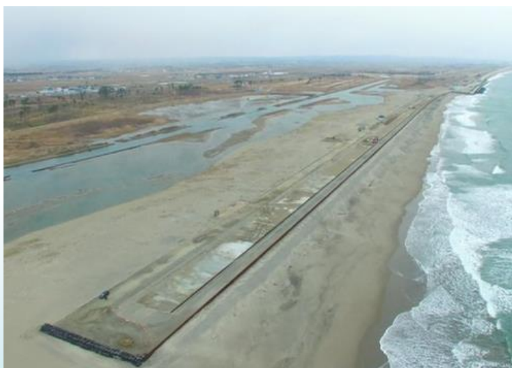
仙台海岸（深沼南工区）平成28年度完成予定
