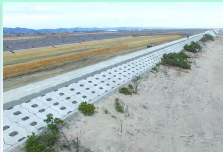
山元海岸（笠野工区）平成26年7月完成
