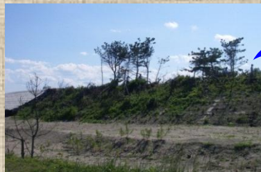
復旧工事着手前の状況（海側から望む）
