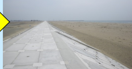
名取市(関上・北釜工区) 海岸堤防完成状況(2014.4.28撮影)
