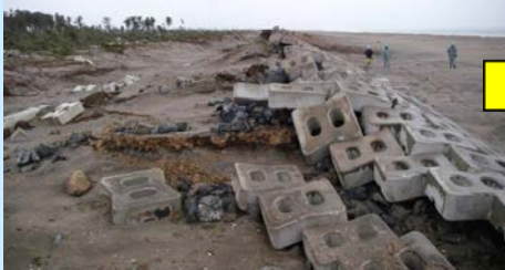
名取市(関上・北釜工区) 海岸堤防被災状況(2011.5.22撮影)
