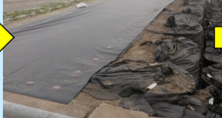
名取市(関上・北釜工区) 海岸堤防応急復旧状況(2011.8.30撮影)
