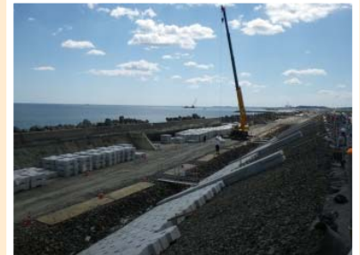
▲施工中の工事現場の状況
