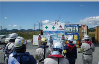
施工現場合同安全点検
