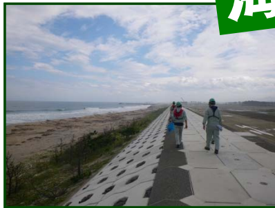
徒歩による点検状況
