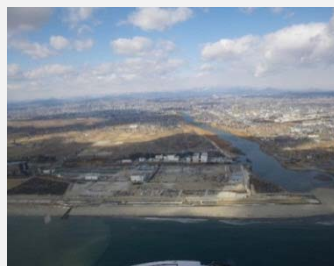
蒲生浄化センター付近
