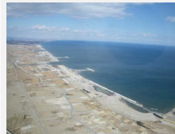
磯浜漁港より北側を望む
