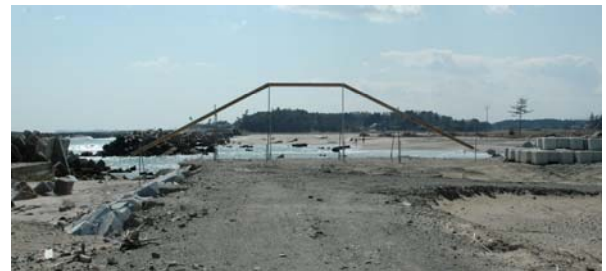
6. 2mから7. 2mにかさ上げし、「粘り強い構造の堤防」を整備。模型の大きさと復旧される。
