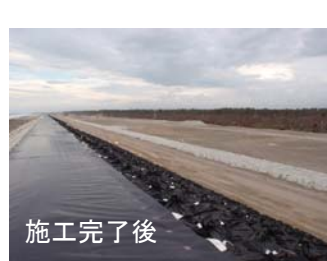
【蒲崎海岸・・・大型土嚢を使って施工した波浪・高波対策の仮設堤防】
