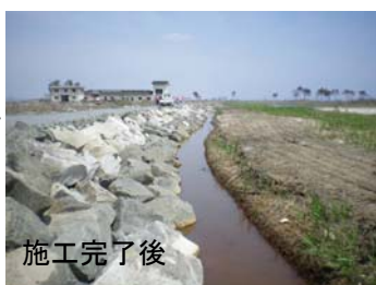
【中浜海岸・・・高潮対策として、沿岸域を浸水から守るための仮設堤防】
