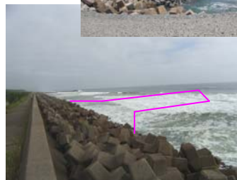
平成21年 8月着工前 S5号ヘッドランド建設位置
