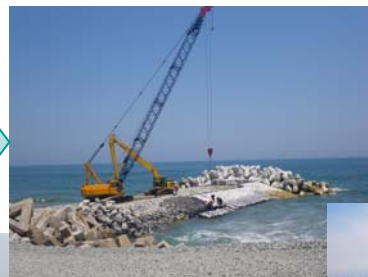
平成22年6月 縦堤部に被覆石を 設置している様子
