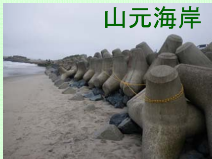
砂が減少し、ブロック下の石1個と、後ろの消波ブロックに支えられている状態。前方の両足が浮いているため、転倒の危険性がある。
