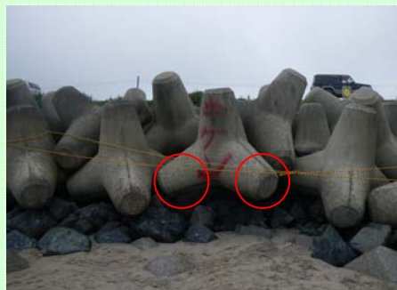
砂が減少し、ブロック下の石1個と、後ろの消波ブロックに支えられている状態。前方の両足が浮いているため、転倒の危険性がある。
