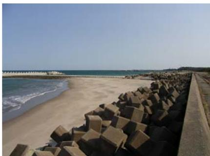
S2号ヘッドランドの北側に養浜工で砂を供給しました。
