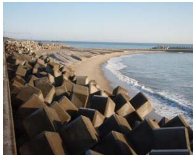
S2号ヘッドランドの南側に養浜工で砂を供給しました。
