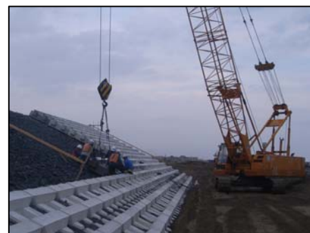
◆被覆ブロック据付作業◆
