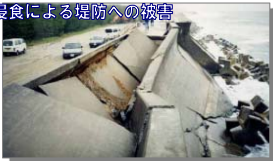
砂浜が侵食され、消波ブロックが沈み、海岸堤防に被害を受けました。(平成3年山元町中浜地内)
