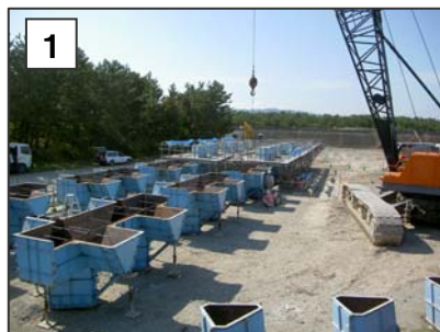
1 型枠を組み立て、コンクリートを打ち込んでいきます。大きなブロックなので足場を組んでの作業です。
