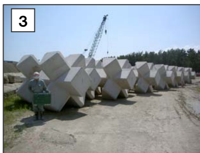
3 型枠を外して、ガッチリとしたブロックの完成です。
