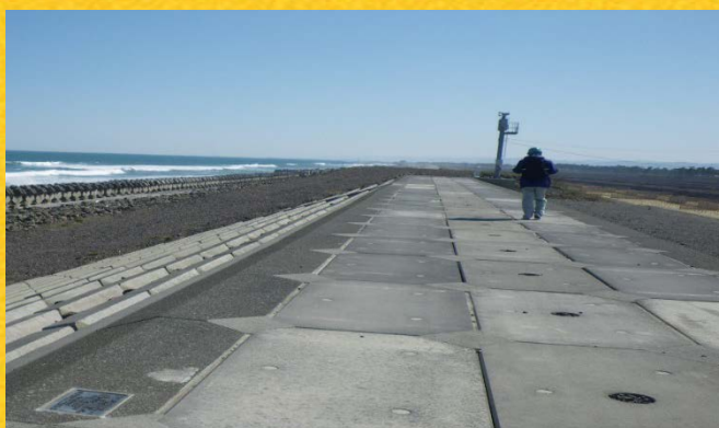
▲堤防天端の点検 (岩沼海岸)
