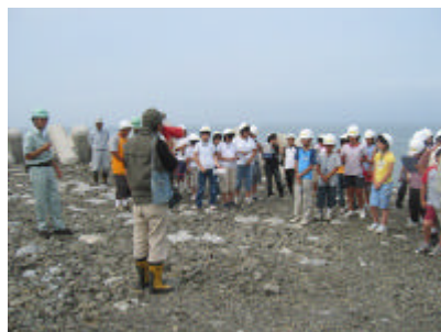
工事中のS4号ヘッドランドの点検
