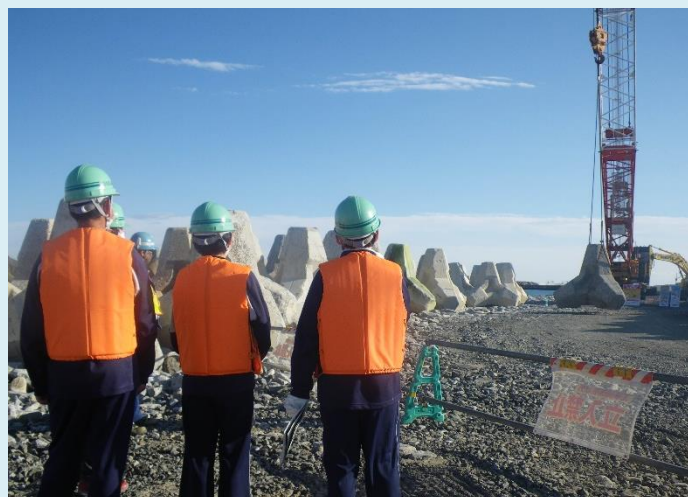
▲消波ブロックの運搬作業を見学している様子
