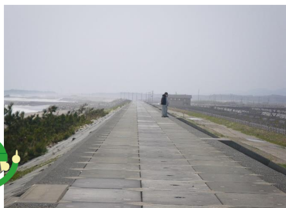
山元海岸（中浜工区）
