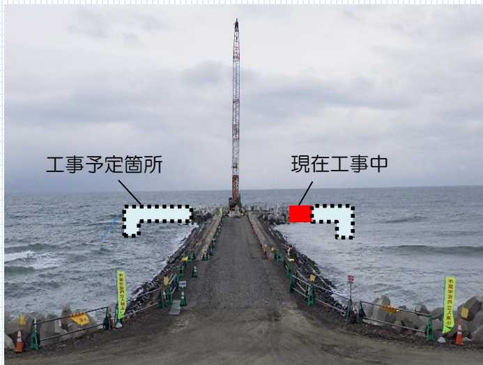
▲工事前の状況
