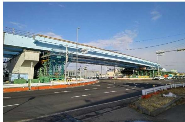
▲送り出し工法で架設された上部工【仮称】箱堤高架橋(R5.3撮影)
